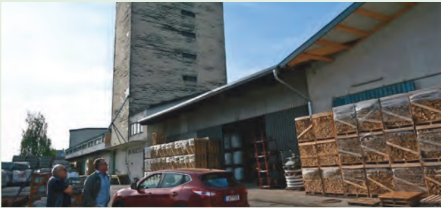
Ehemaliger Getreidespeicher in Ried neben dem Bahnhof
