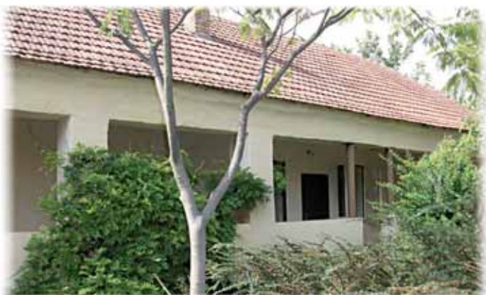
Ein Blick in den Innenhof des Hauses – einst ein sehr gepflegter Blumen- und Rosengarten
