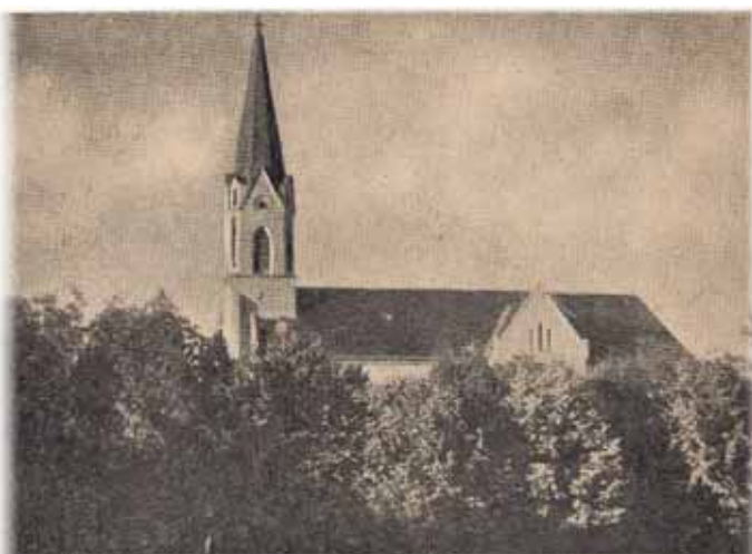
Die ehemalige Pfarrkirche von Ernsthausen, 1882 erbaut – 1946 abgerissen
